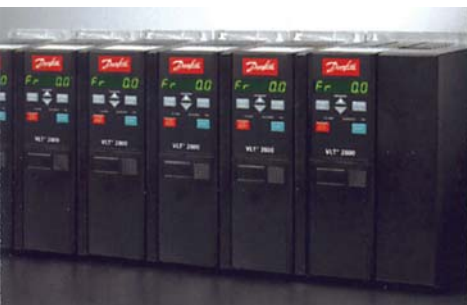
Реальный монтаж бок о бок
